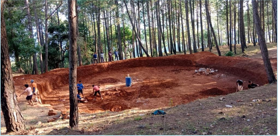
रिचार्ज पोखरी, सुनिल स्मृति ३, मिझीड, रोल्पा: पानी सञ्चित क्षमता: ३१४००० लिटर
