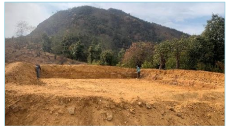
रिचार्ज पोखरी, गंगादेव ४, पाखापानी, रोल्पा: पानी सञ्चित क्षमता: १२०००० लिटर
