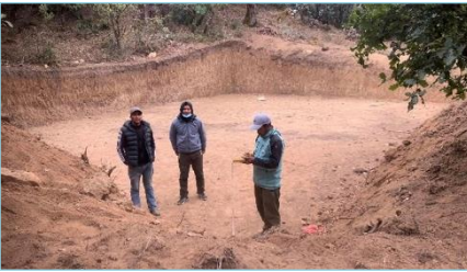
रिचार्ज पोखरी, गंगादेव ४, पाखापानी, रोल्पा: पानी सञ्चित क्षमता: १२०००० लिटर
